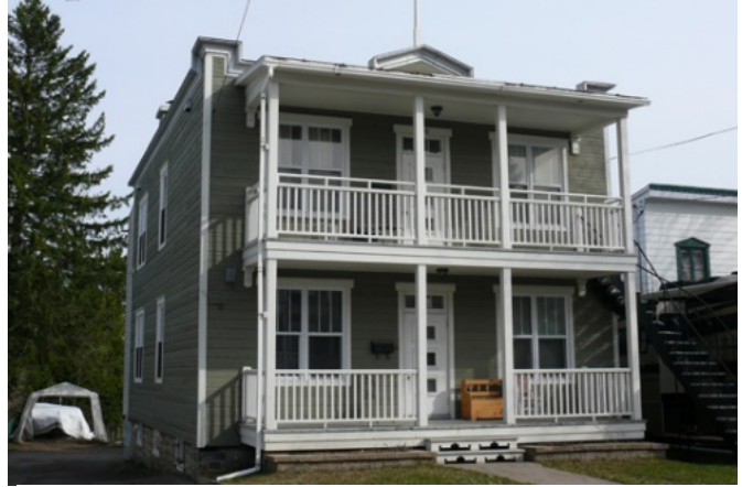
198. Duplex (688-690, boulevard Louis-XIV), bâti entre 1915 et 1923, et doté de galeries et d'un parapet décoratif.
