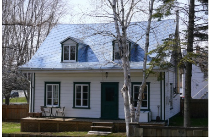
164. La maison Bédard-Falardeau (9191, rue Hector-Laferté), présente une toiture recourbée en tôle à la canadienne et un revêtement de bois typique du modèle de la maison néoclassique québécoise. Elle est bâtie entre 1860 et 1878.
