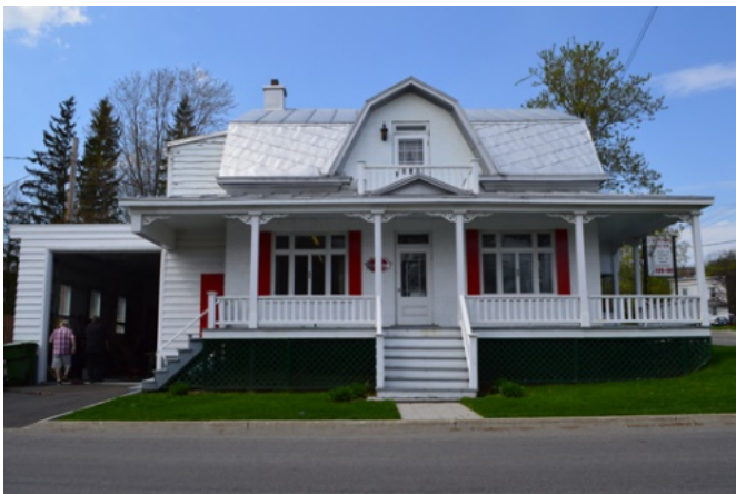
175. La maison Villeneuve-Bélanger (5555, 1 re Avenue), bâtie entre 1894 et 1901, comporte une grande galerie sur deux façades ainsi qu'une grande lucarne centrale.
