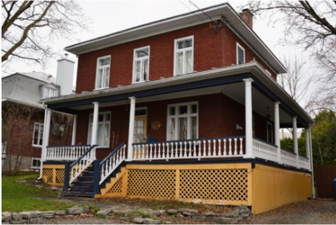
190. La maison Cléophas-Rainville (7570, 1 re Avenue), construite en brique entre 1922 et 1943, a toutes les caractéristiques d'une maison cubique.
