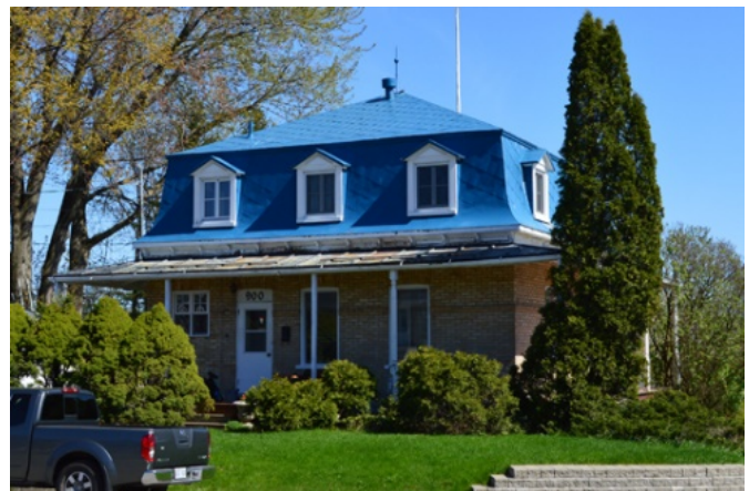
178. La maison Magnan-Sansfaçon (900, place Pigalle), bâtie en 1915 en brique est une maison à mansarde au toit à quatre versants. Elle est dotée d'une tourelle du côté sud.
