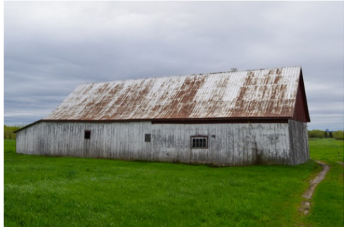
226. Grange-étable (1712, rue du Vignoble).
