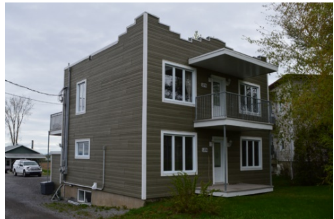
202. Duplex situé au 1374-1378, boulevard Louis-XIV, construit entre 1950 et 1956 et doté d'un parapet en gradins.
