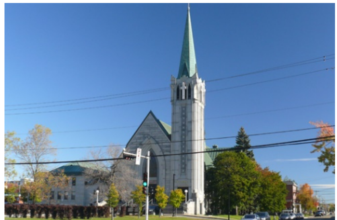
71. L'église Saint-Rodrigue, le principal repère visuel de cette unité de paysage.
