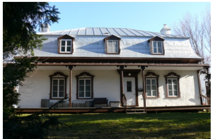
176. La maison Jobin-Bédard (1216, rue du Maine), bâtie en pierre entre 1770 et 1826 a vu son toit à deux versants d'origine remplacé par un toit mansardé à la fin du 19 e siècle.
