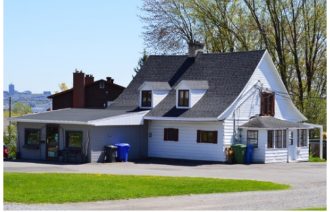
160. Le 6469, 3 e Avenue Ouest, aurait été construit entre 1770 et 1820. On reconnaît sa haute toiture malgré les transformations subies.
