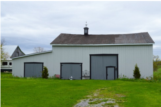
231. Grange-étable (1766, rue du Vignoble).
