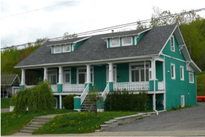
205. La maison Pageau-Bédard (17-19, rue de la Polyvalente), bâtie entre 1920 et 1949, est revêtue de bardeau de bois et possède des composantes issues de l'Arts & Crafts.
