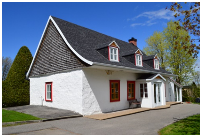
157. La maison Lévesque (1300, avenue Lévesque), est le seul exemple de maison rurale d'inspiration française de l'inventaire. Construite entre 1730 et 1780, la maison en pierre revêtue d'un crépi, bien assise au sol, possède une haute toiture à la française. La base recourbée du toit et les lucarnes sont sans doute des adaptations du 19 e siècle.
