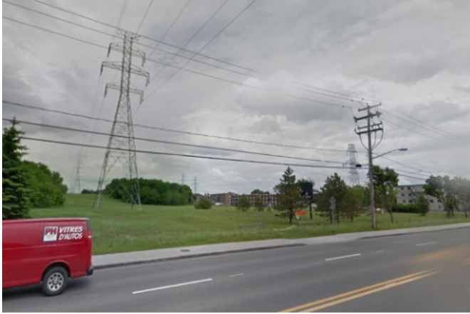
102. Lignes de transmission électriques qui traversent le boulevard Henri-Bourassa.
