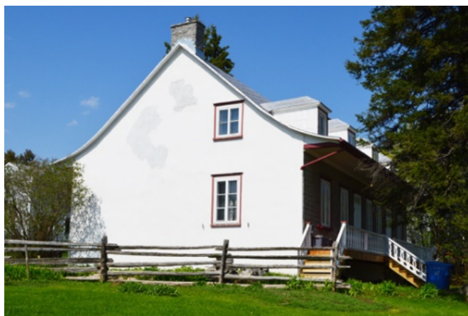
162. La maison Marguerite-Cloutier (6541, avenue Monette), a été bâtie entre 1850 et 1880. Elle possède le profil typique de la maison néoclassique québécoise avec son toit en pente moyenne dont le larmier recourbé se prolonge au-dessus d'une galerie. Elle comporte une façade en pierre de taille rehaussée de boiseries décoratives.
