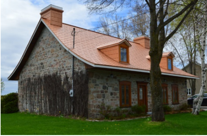
159. La maison Bédard-Lefebvre (1856, rue du Vignoble), bâtie entre 1800 et 1813, possède un carré en pierre et des cheminées massives.
