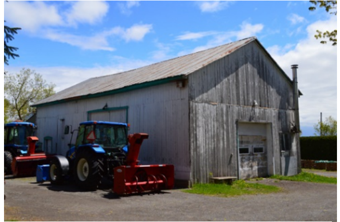
230. Grange-étable (1566, rue du Vignoble).
