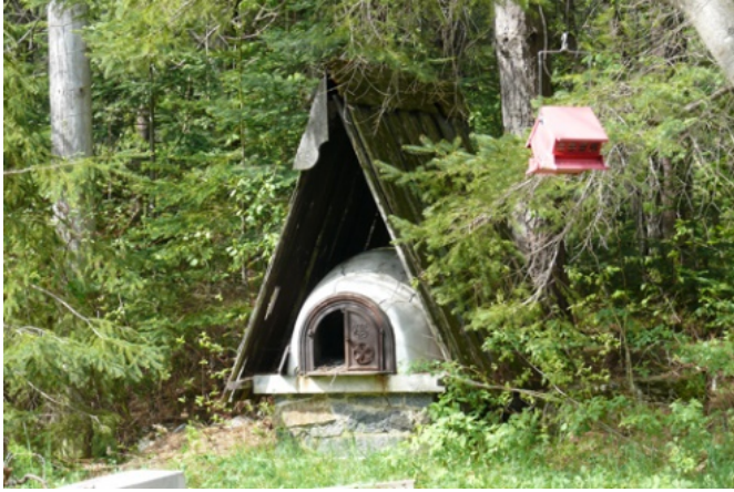
241. Four à pain (2205, rue de Belleville).
