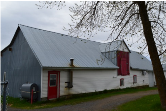
227. Grange-étable (1778, rue du Vignoble).
