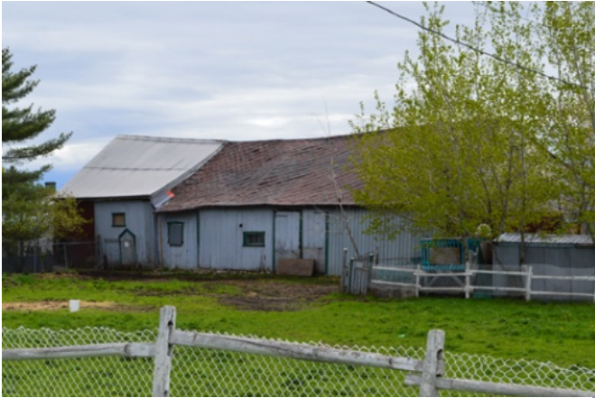
225. Grange-étable (1654, rue du Vignoble).
