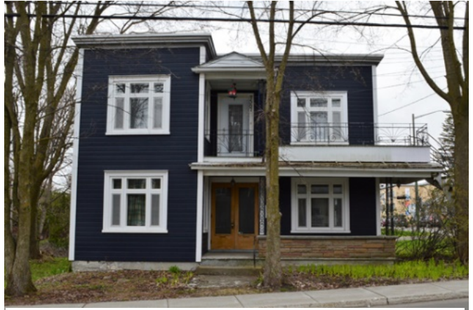
200. La maison Joseph-Albert-Delage (7585-7587, 1 re Avenue), construite entre 1917 et 1941 et dotée d'un toit plat, comporte deux logements superposés.
