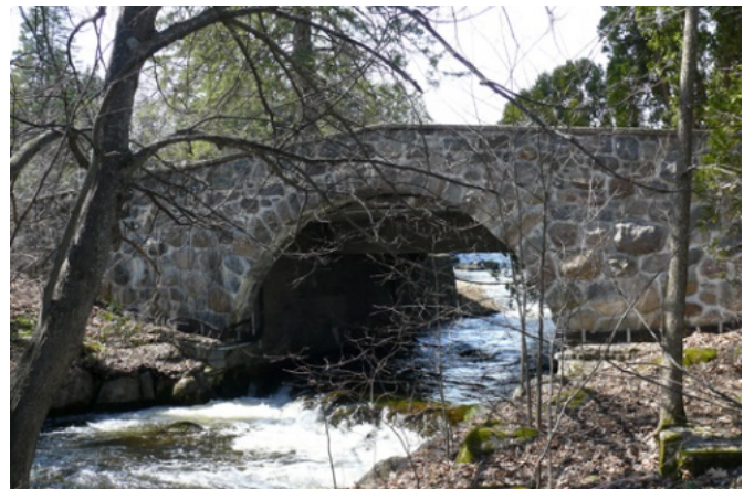
101. Pont en pierre dans le parc des Moulins (ancien zoo).
