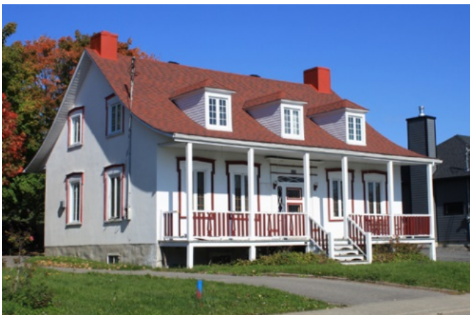
257. La maison Déry était construite de murs structuraux en brique qui avaient récemment été revêtus d'un crépi. Elle a été détruite en 2017 (1625, rue du Vignoble).
