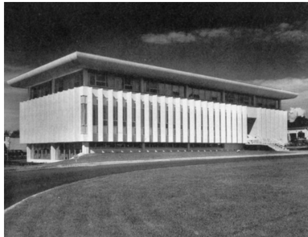
53. Hôtel de ville de Charlesbourg construit en 1965. Source : Martin Dubois, L'architecture municipale à Québec : 100 bâtiments publics . Québec, Les Publications du Québec, 2009, p. 28-29.
