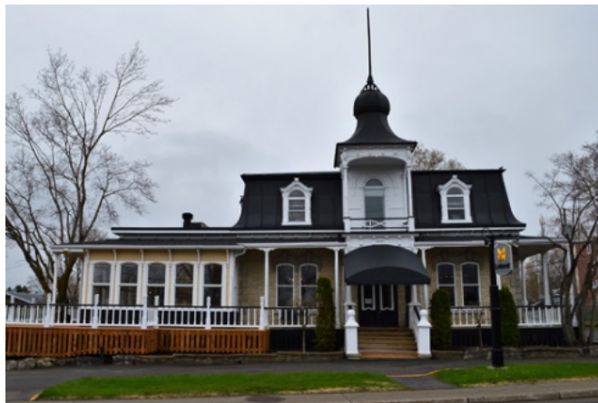
171. La maison Olivier-Bresse (7685, 1 re Avenue), bâtie entre 1893 et 1896, est un excellent exemple de maison de style Second Empire avec sa tourelle centrale et son ornementation élaborée.
