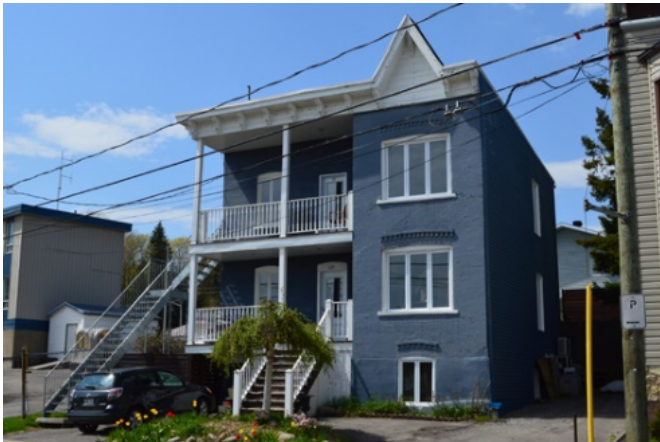
201. Duplex situé au 125-127, 58 e Rue Est, bâti entre 1942 et 1949, en brique et doté d'une corniche saillante.
