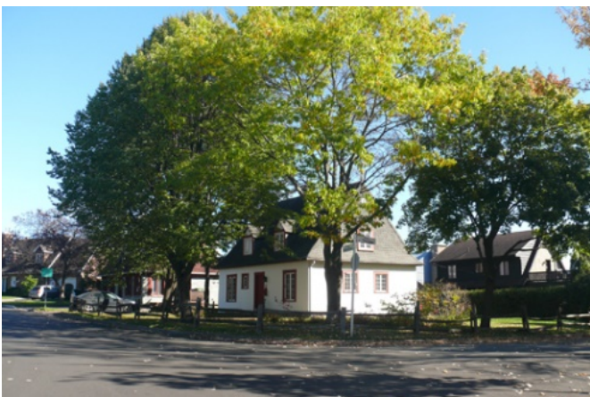
81. Maison unifamiliale d'inspiration « Nouvelle-France » construite dans les années 1970 et située sur une rue résidentielle du quartier.
