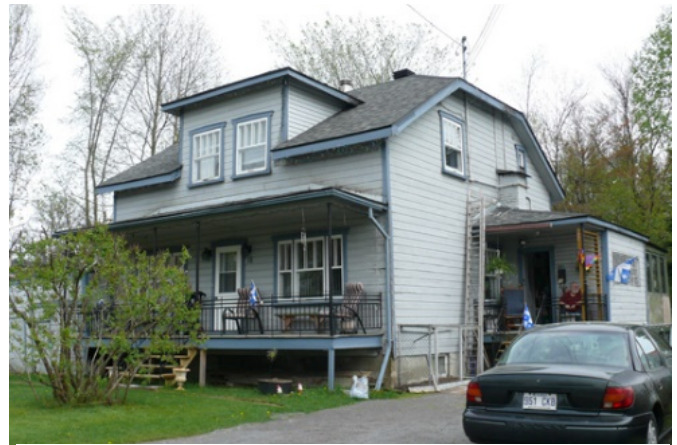
188. Le 16, rue des Bourgeois est bâti entre 1920 et 1950, et est un cottage vernaculaire américain avec toiture à demi-croupes.
