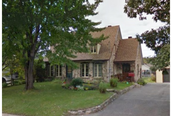
279. La maison construite pour Albert Potvin avec des pierres provenant de la Maison de la Montagne se dresse sur la rue du Vice-Roi, à l'angle de l'avenue du Bourg-la-Reine. Les vestiges du manoir se trouvaient à la gauche de cette maison, soit sur le terrain voisin. Source : Google Streetview
