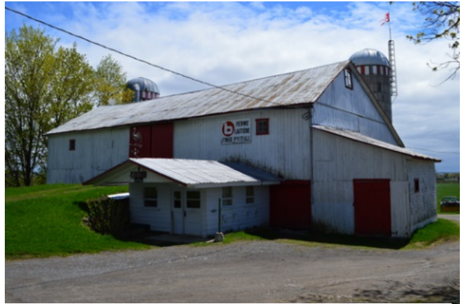
224. Grange-étable (1586, rue du Vignoble).
