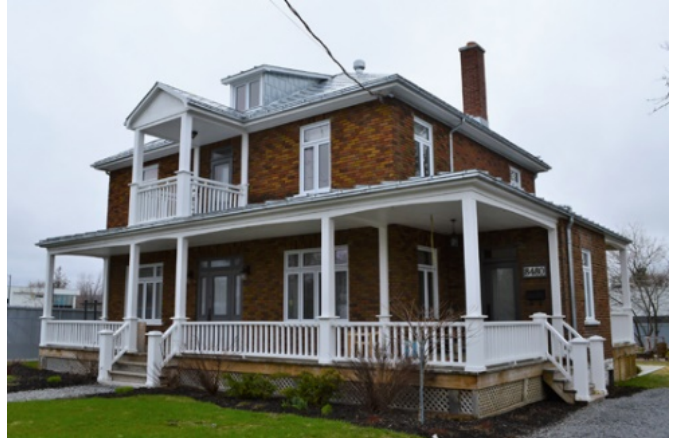
189. La maison Pierre-Bédard (8480, 1 re Avenue), bâtie entre 1932 et 1945, est un bel exemple de maison cubique en brique.
