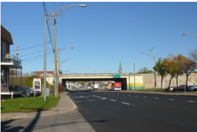
57. Pont d'étagement (viaduc) de l'autoroute Félix-Leclerc au-dessus de la 1 re Avenue. Cette autoroute a coupé la paroisse Saint-Rodrigue en deux.
