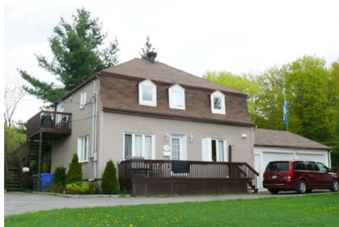
270. Cette maison fait partie des 25 bâtiments de valeur patrimoniale faible de l'inventaire (778, côte Bédard).
