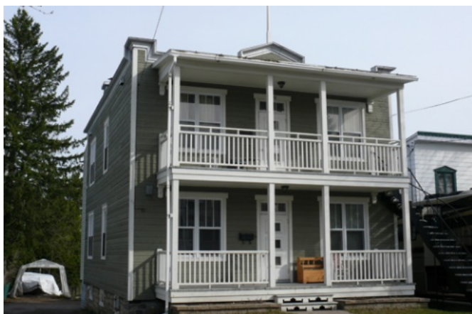
269. Cette maison Boomtown fait partie des 121 bâtiments de valeur patrimoniale bonne de l'inventaire (688-690, boulevard Louis-XIV).
