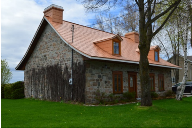
255. La maison Bédard–Lefebvre est l'une des rares maisons en pierre de l'arrondissement de Charlesbourg. Son carré de pierre a été dégarni de son crépi durant les années 1970 ou 1980 (1856, rue du Vignoble).
