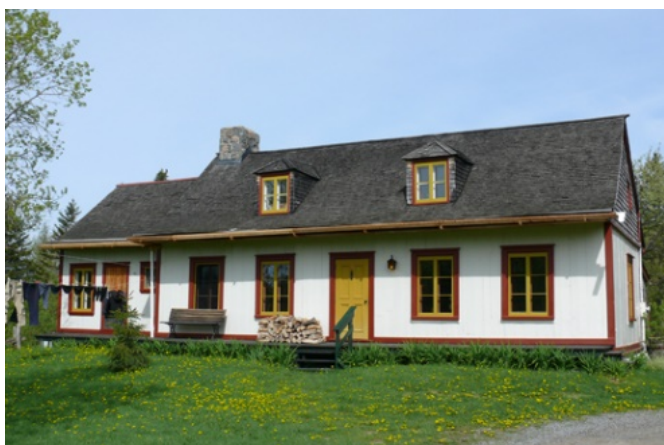
253. La maison Villeneuve, entièrement construite en bois, de la charpente au revêtement de toiture, en passant par les portes et fenêtres, le parement des murs et l'ornementation (1761, avenue de la Rivière-Jaune).
