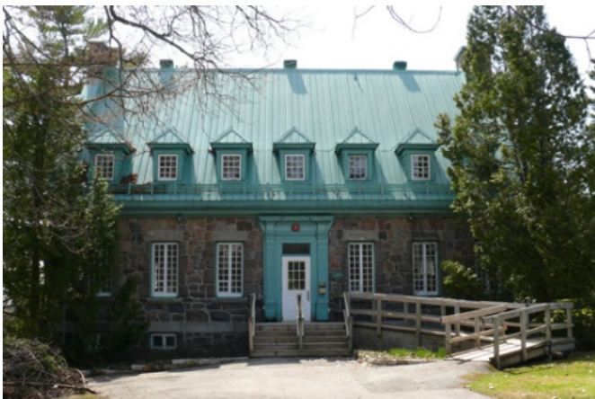
208. La maison Brassard (8191, avenue du Zoo), bâtie en 1931–1932 dans l'ancien jardin zoologique.
