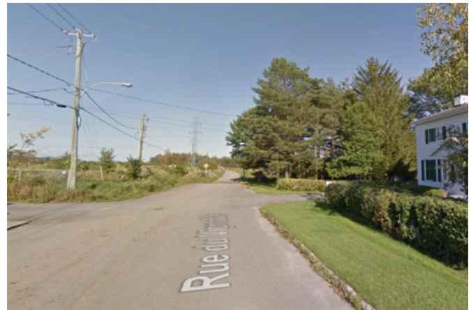
154. Percée visuelle à l'extrémité est de la rue du Vignoble où l'on perçoit des pylônes électriques. Source : Google.
