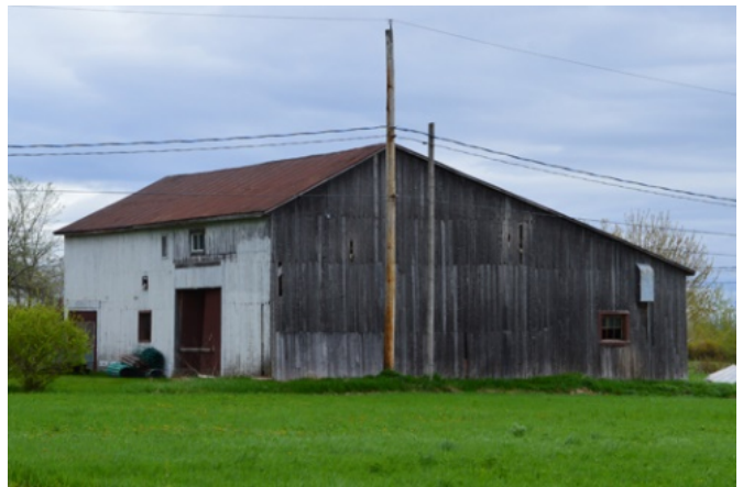
228. Grange-étable (1748, rue du Vignoble).
