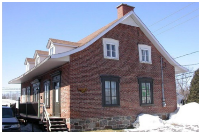
258. La maison Berthiaume avait conservé ses murs structuraux en brique apparents jusqu'à sa démolition vers 2012 (15061, boulevard Henri–Bourassa).
