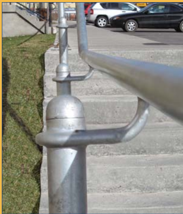
Attaches des mains courantes
