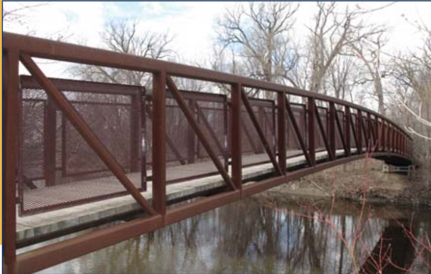
Garde-corps extérieurs au-dessus d'un cours d'eau
