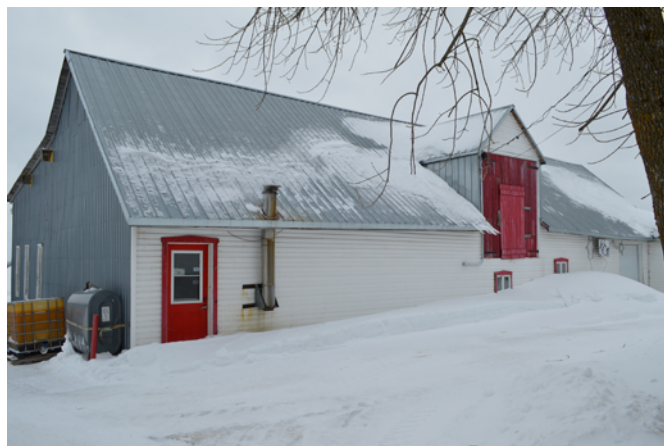
Grange-étable de la maison du 1778, rue du Vignoble.
