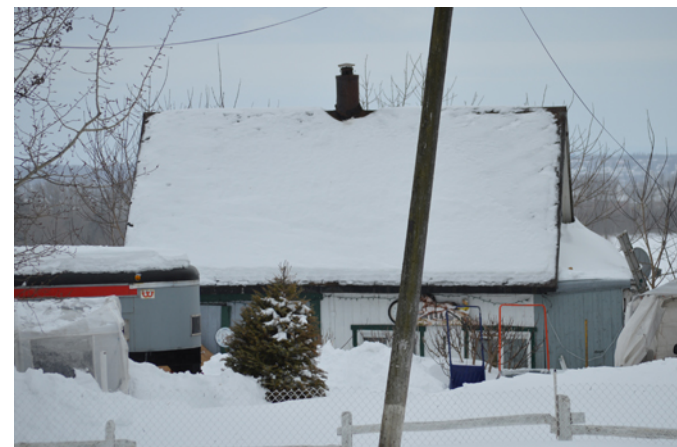
Hangar de la maison Camille-Proteau, 1654, rue du Vignoble.
