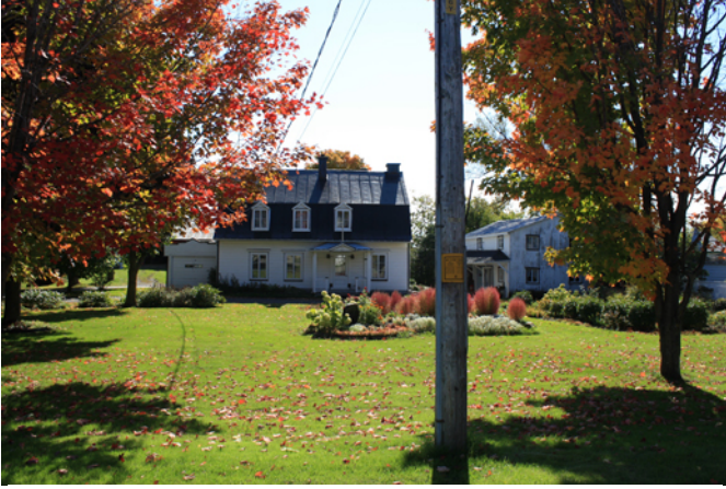
17. Ferme des Proteau au 1586, rue du Vignoble.
