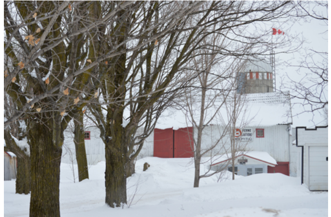
Grange-étable de la maison Auguste-Proteau, 1586, rue du Vignoble.
