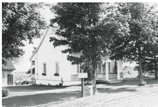
Façade nord, face à la rue, de la maison Théophile-Bédard en 1970.
