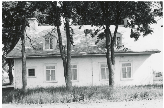
Façade nord, face à la rue, de la maison François-Xavier-Bédard en 1970
