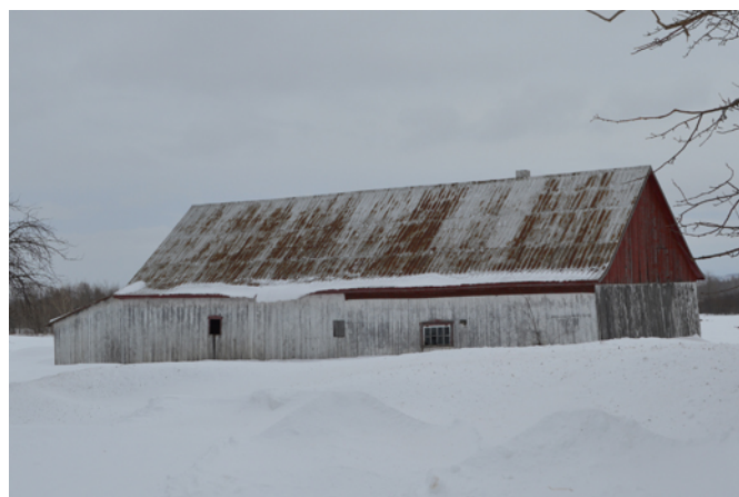
Grange-étable de la maison Louis-Paradis, 1712, rue du Vignoble.
