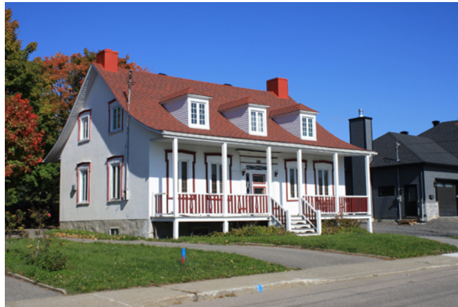
La maison Joseph-Déry, 1625, rue du Vignoble.
