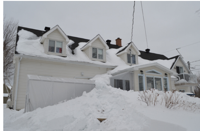
Façade sud de la maison du 1778, rue du Vignoble.
