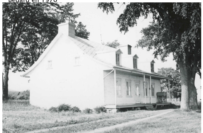
Façade ouest et sud de la maison François-Xavier-Bédard en 1970.
