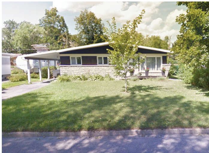
IMAGE 1 – PHOTOGRAPHIE DU BÂTIMENT EXISTANT
