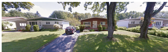
IMAGE 3 – PHOTOGRAPHIE DU BÂTIMENT QUI FAIT FACE AU BÂTIMENT PROJÉTÉ ET SES DEUX BÂTIMENTS ADJACENTS
