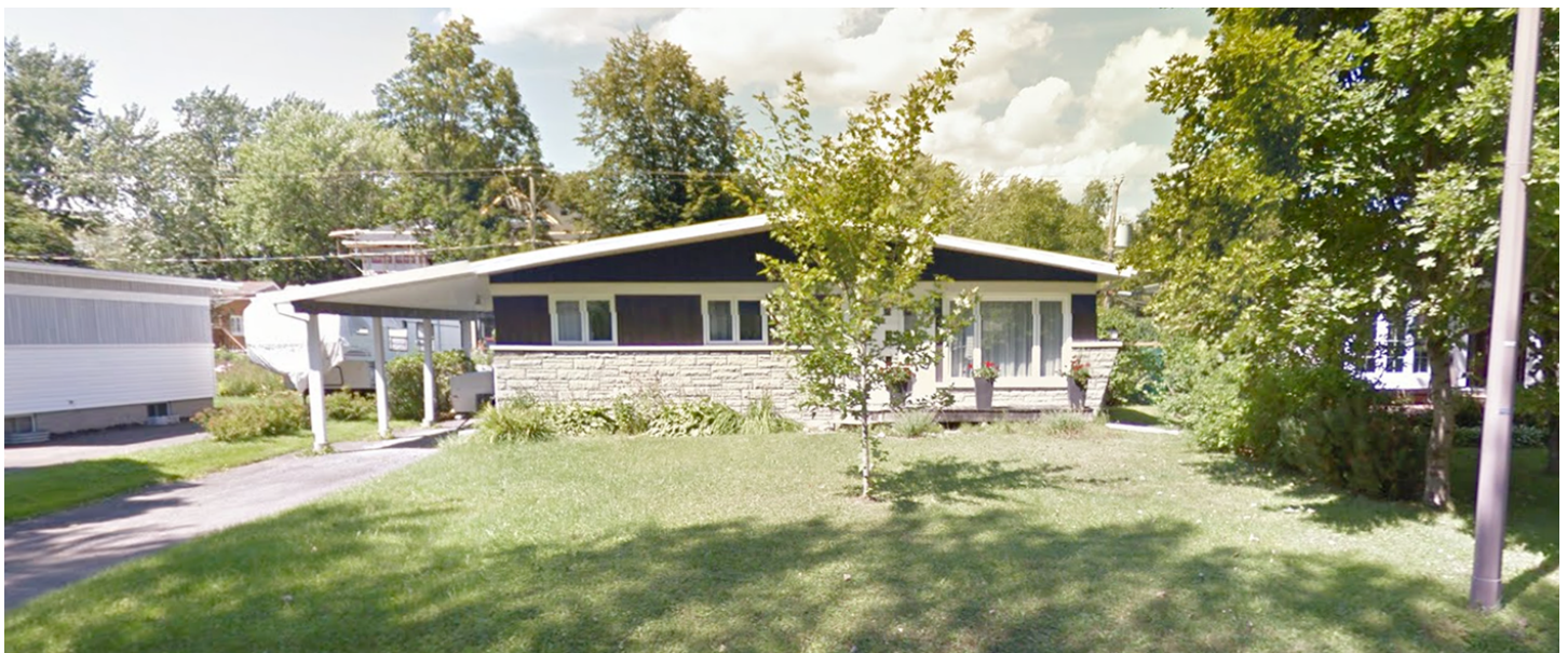
IMAGE 1 – PHOTOGRAPHIE DU BÂTIMENT EXISTANT
