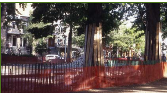
Installation de protecteurs autour des troncs d'arbres.
