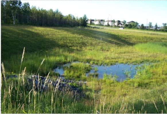
BASSIN NORDIQUE N° 3 – EXEMPLE PENTE FAIBLE
