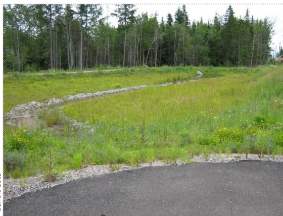
BASSIN CASSIOPÉE N° 78 - EXEMPLE CHENAL D'ÉCOULEMENT SINUEUX POUR LE RÉSEAU MINEUR
