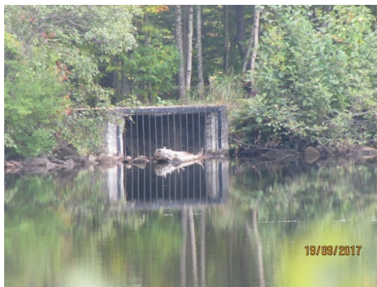
Photo 2 – Barrage à Monette
