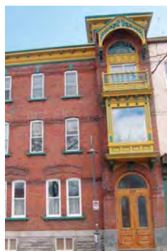
Maison à toit plat et saillie ornementale
