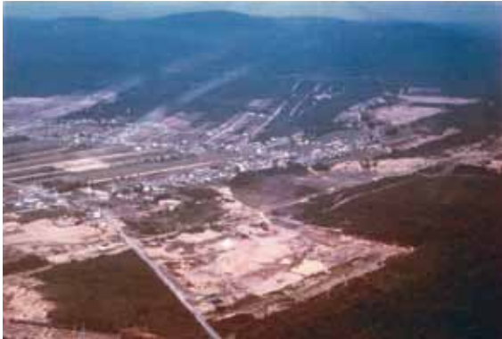
Vue aérienne des sablières, en 1966. Archives de la Société d'art et d'histoire de Beauport, collection Benoît Robert.
