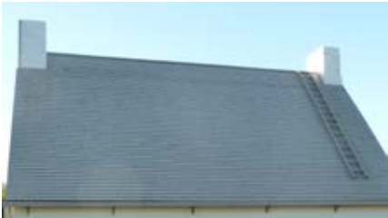
Toiture en bardeaux de cèdre
