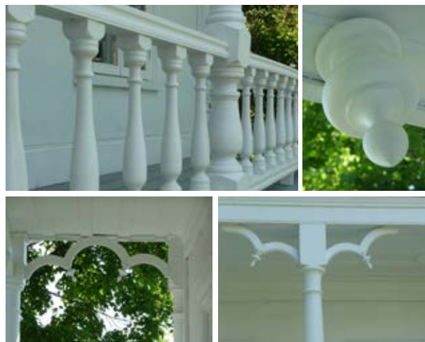
L'ornementation extérieure de la maison comprend des garde-corps aux balustres tournés, des colonnes, des fuseaux décoratifs et des chambranles moulurés. Photo: Claude Corriveau, 2015
