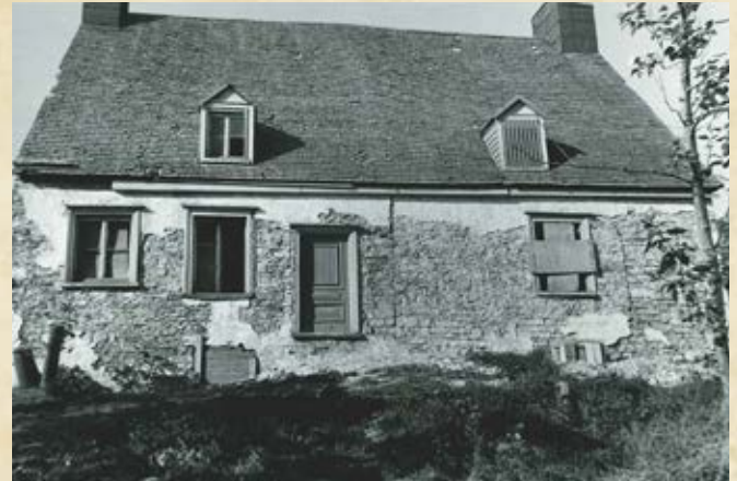
Mur long-pan sud lors de son nettoyage, vers 1975. À l'extrême droite de la photographie, une porte est obstruée. Au centre, le joint vertical séparant les parties est et ouest de la maison est visible. Autour de la porte, les reprises dans la maçonnerie montrent qu'elle est percée après la construction de la maison. Ministère de la Culture et des Communications -14310-002802-AN I
