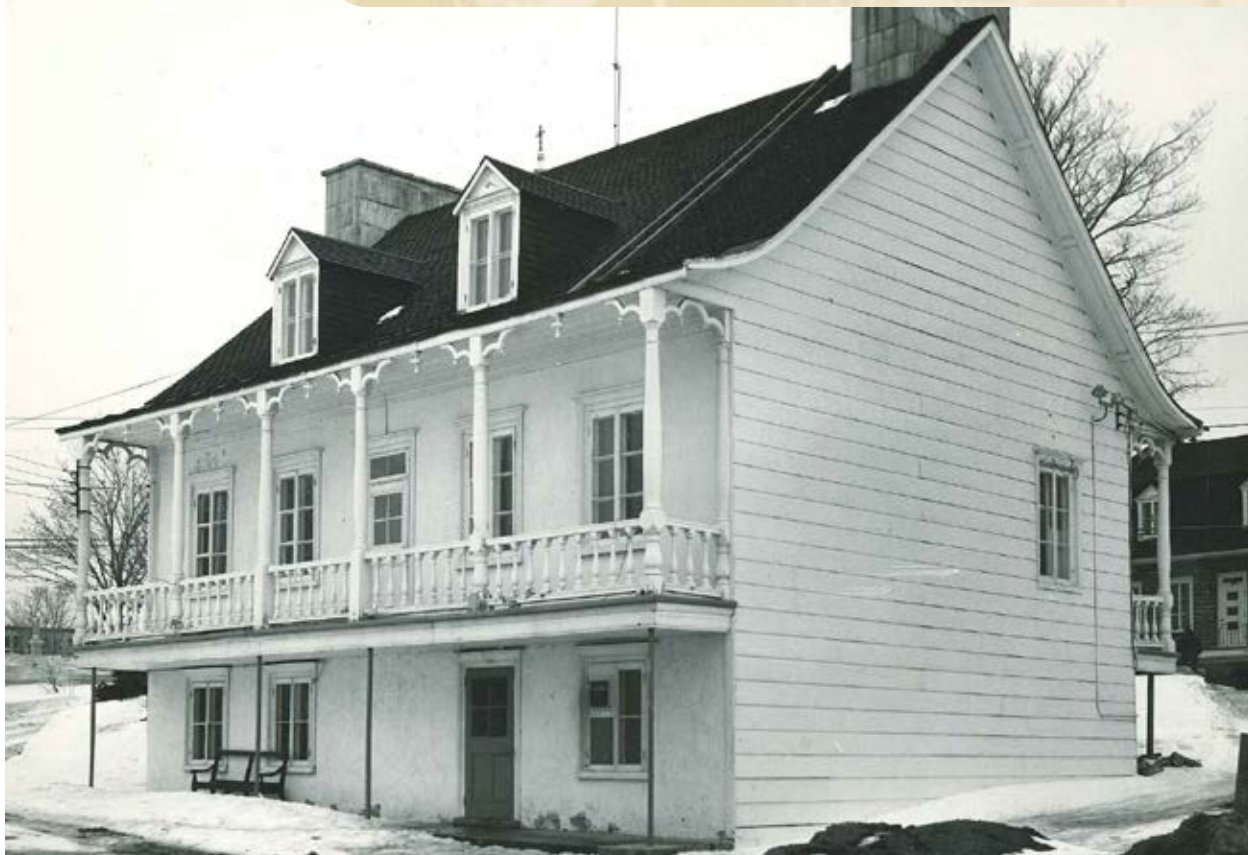
La façade arrière de la maison, 1965. En suivant la dénivellation du terrain, les fondations élevées de la maison forment un étage du côté sud. La cave peut servir à d'autres usages que l'entreposage. Ministère de la Culture et des Communications, 76-660 (45)
