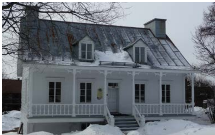
La maison, 2015. Autrefois, le toit à deux versants était recouvert de bardeaux de cèdre alors qu'aujourd'hui, il est recouvert de tôle à baguettes. Le recouvrement des murs en pierre est en crépi sur les façades et le côté ouest, alors que des planches à clin lambrissent le mur du côté est. Photo: Claude Corriveau
