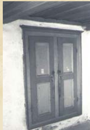
Armoire encastrée, 1971. La porte extérieure nord, dans la partie ouest, est bouchée à une date inconnue. À l'intérieur, y est installée cette armoire encastrée. PCan-159-00-RE.6(1)-A-24
