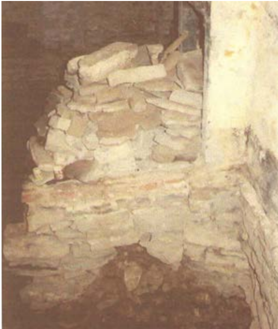
Fondations présumées de l'ancienne base du feu de forge. Cette masse d'environ 1,52 m sur 1,52 m sert de base à la dalle de foyer de la cheminée, située à l'est de la maison actuelle. Ministère de la Culture et des Communications-RPic-19830706-044
