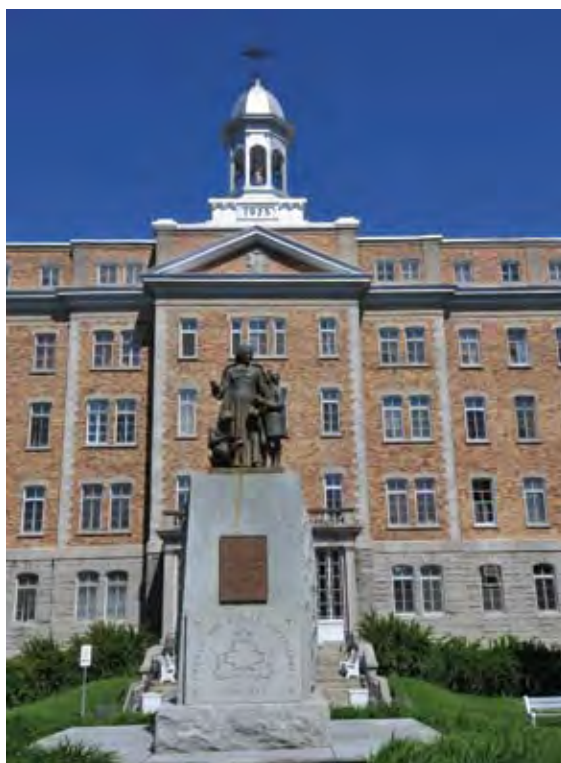
Pavillon Montcalm. Photo: Louise Leblanc, 2009. La monumentalité de la façade en brique, le toit plat et la symétrie rigoureuse du pavillon Montcalm rendent compte des principes du système Beaux-Arts. Le dôme surplombant l'avant corps central, accentue l'aspect imposant du bâtiment.
