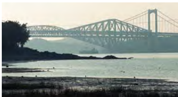
Pont de Québec. Photo: Ville de Québec.
