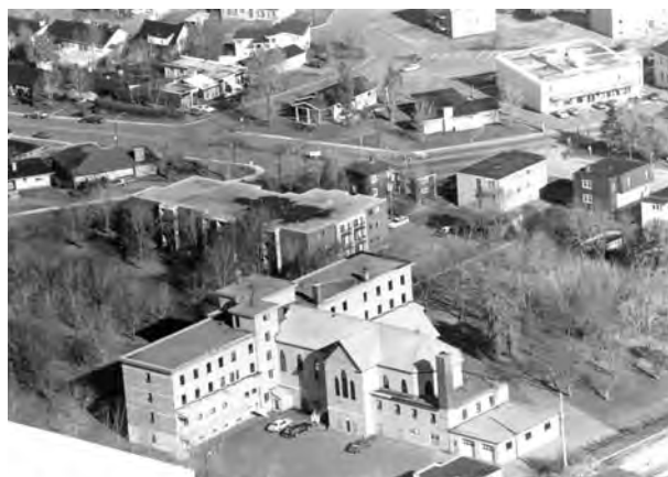
Façade arrière de la maison provinciale des Frères de Saint-Vincent-de-Paul. Photo : R.P. Monnier. BAnQ, Centre d'archives de Québec, Inventaires des biens culturels, E6,S8,SS2,D82.126,P18A, 1982.126.
