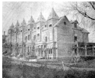
La terrasse Joseph-Abraham-Gagnon en construction. Archives de la Société d'art et d'histoire de Beauport, fonds Gagnon-Saulnier.
