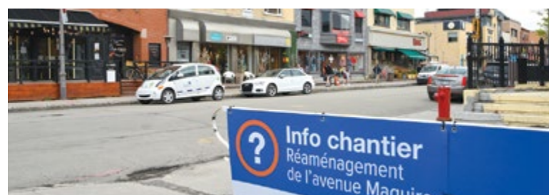
Des bureaux Info-Chantier ont été installés pour répondre à vos questions.
