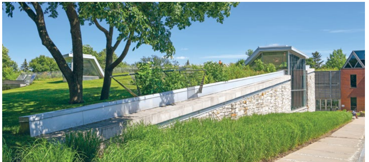
Toiture verte de la bibliothèque Paul-Aimé-Paiement, arrondissement de Charlesbourg.
