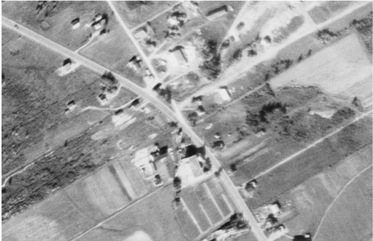
Chapelle et couvent des Soeurs du Bon-Pasteur (1948)
