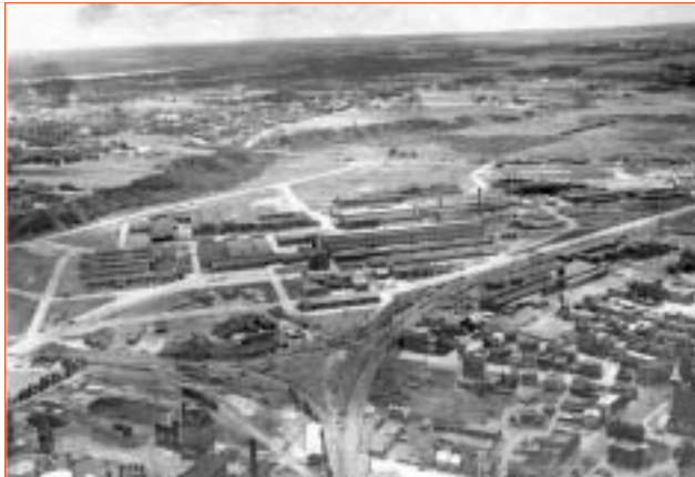
Vue aérienne de l'arsenal en 1949. (Archives de la Ville de Québec, fonds W. B. Edwards inc.).
