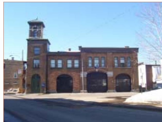
La caserne de pompiers sur l'avenue des Oblats.
