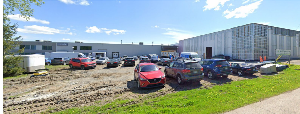
Exemple d'agrandissement d'un bâtiment industriel
