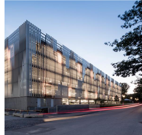
Stationnement étagé Copenhague_ 3XN
