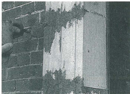
B) Application d'un mortier en plusieurs couches
