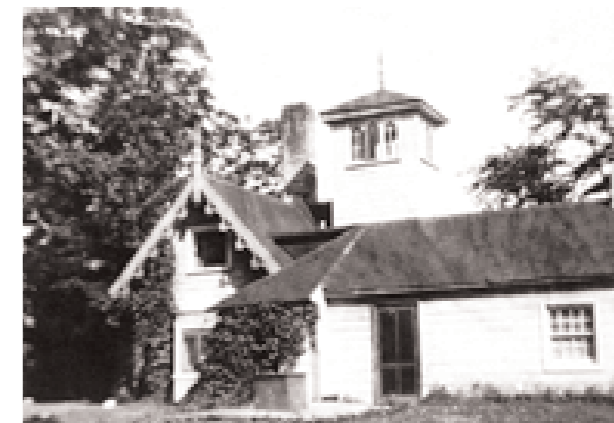
Bagatelle vers 1920, vue de l'avenue James-LeMoine. L'aile abritant la cuisine est plus basse que le reste du bâtiment. Le raccord en saillie complique davantage la forme de la toiture. Fondation Bagatelle.
