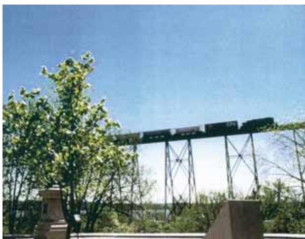
Pont sur chevalets. Photos : Marcel Poudrier.
