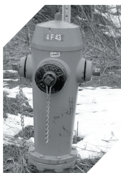
Mise aux normes des bornes d'incendie.
