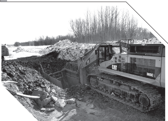
Travaux de remplacement de la conduite du collecteur sanitaire longeant le parc de la rivière Beauport.
