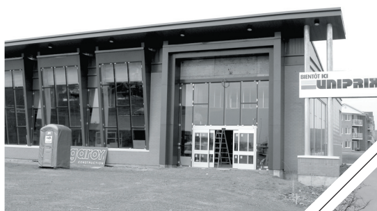
Nouvelle pharmacie sur l'avenue St-David.
