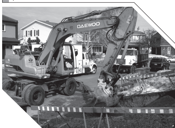
Trois équipes d'excavation ont creusé plus de 280 tranchées.
