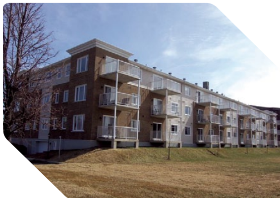
Nouvelles habitations multifamiliales sur le boulevard Sainte-Anne.
