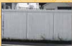
Clôture à mailles losangées avec insertion de plastique à éviter
