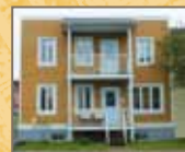
Ajouts de niveaux appropriés • hauteur du mur de fondation hors sol de moins de 120 centimètres • ajout d'un étage
