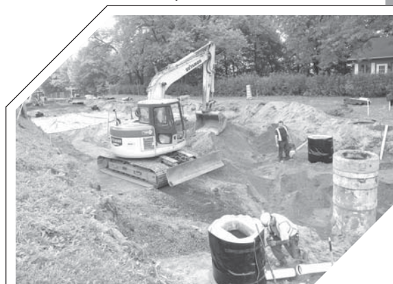
Travaux majeurs sur le boulevard des Chutes.
