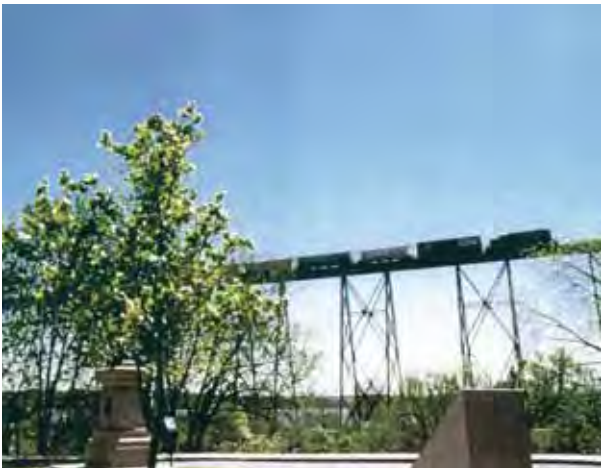
Pont sur chevalets. Photos : Marcel Poudrier.
