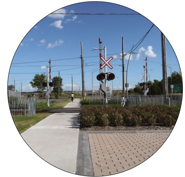
Nouvelle traverse piétonne sécuritaire de la voie ferrée
