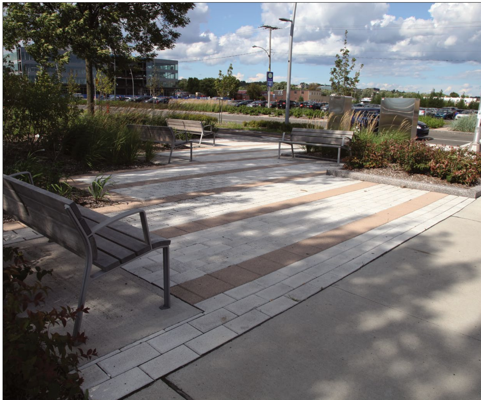
Placette aménagée Intersection avenue D'Estimauville et boulevard Montmorency
