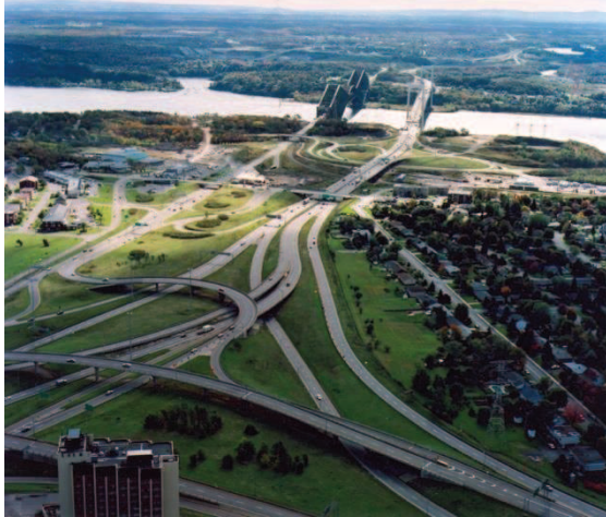
Figure 1 : photographie aérienne, ponts et échangeurs
