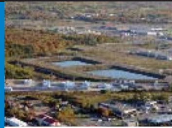
Bassin de rétention
