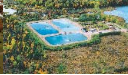
Bassin de rétention
