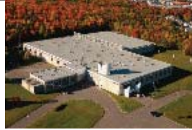
Usine de traitement des eaux
