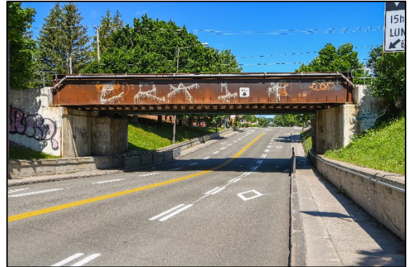
Figure 20 - Viaduc voie ferrée 1 re Avenue
