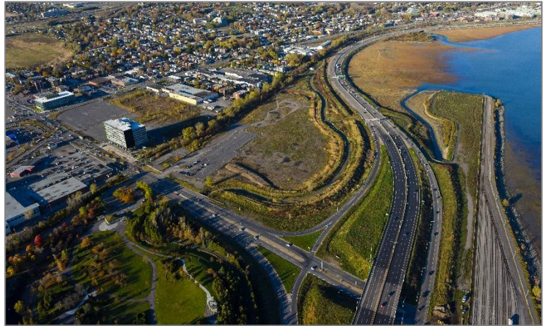
Figure 53 - Ancien dépôt à neige D'Estimauville
