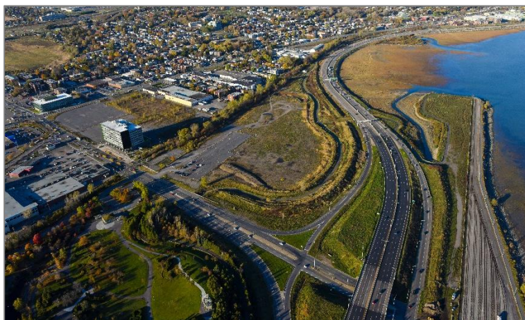
Figure 56 - Ancien dépôt à neige D'Estimauville
