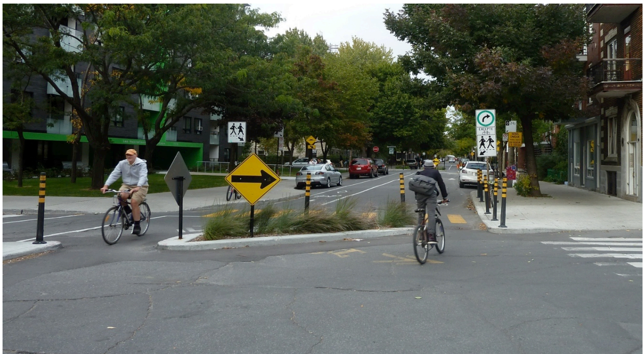
Figure 5. Déviateur perméable aux vélos avec deux ouvertures (rue Gilford, Montréal)
