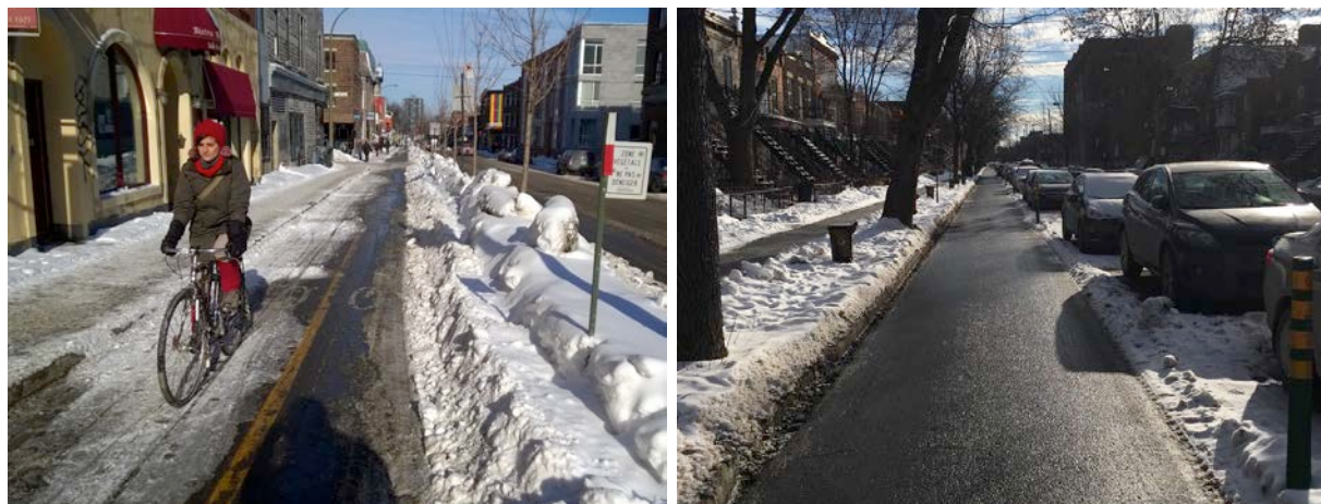
Figure 23. Déblaiement à la charrue (gauche) et au balai rotatif (droite)
