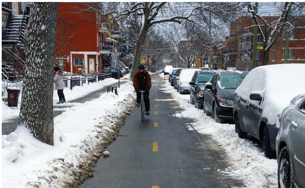
Figure 1. Piste cyclable bidirectionnelle séparée par véhicules en stationnement (rue Boyer, Montréal)
