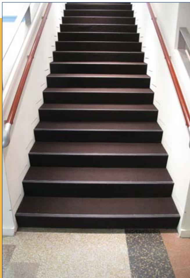
Escalier intérieur avec contremarches fermées
