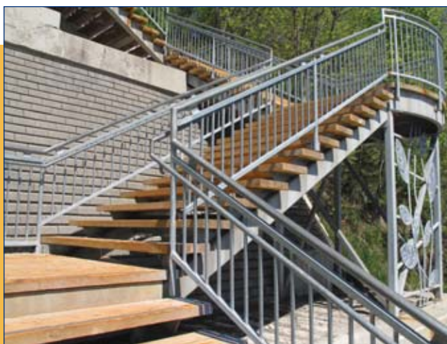
Escalier extérieur à contremarches ouvertes
