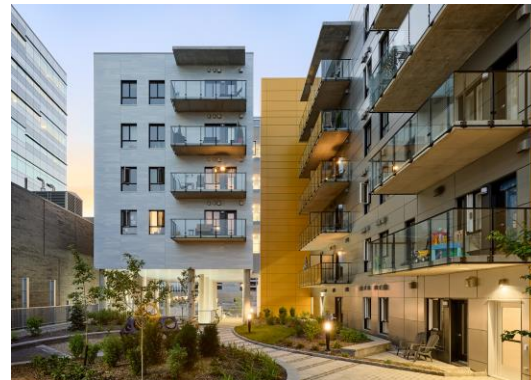
Projet novateur, logement social, Un toit vert
