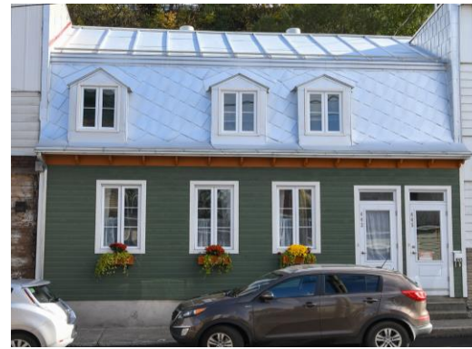
Restauration de bâtiment à valeur patrimonial ou situés dans des secteurs patrimoniaux
