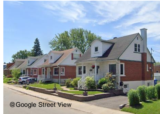
Maisons individuelles, rue de l'Émérillon
