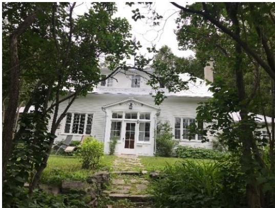
Photo : Maison Timmony, façade actuelle
