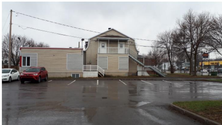
Maison Mauger à démolir
