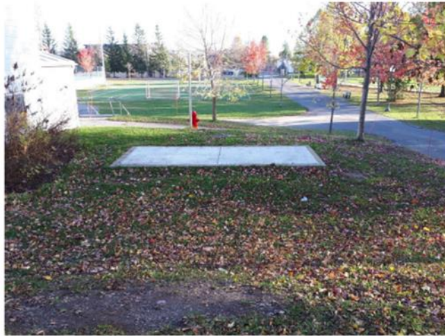
Mécanique du jeu d'eau à récupérer dans chambre souterraine à démolir
