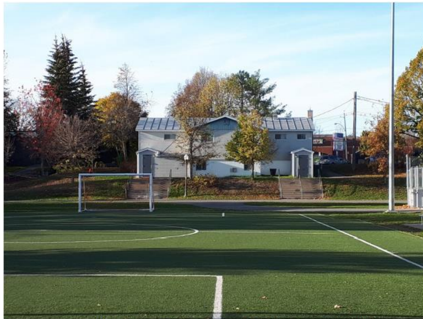
Maison des jeunes-salle des patineurs à démolir
