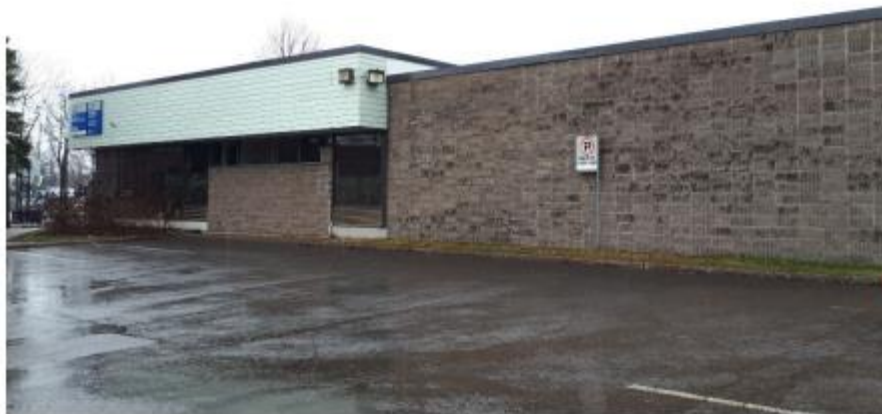
Centre communautaire à démolir, façade avant
