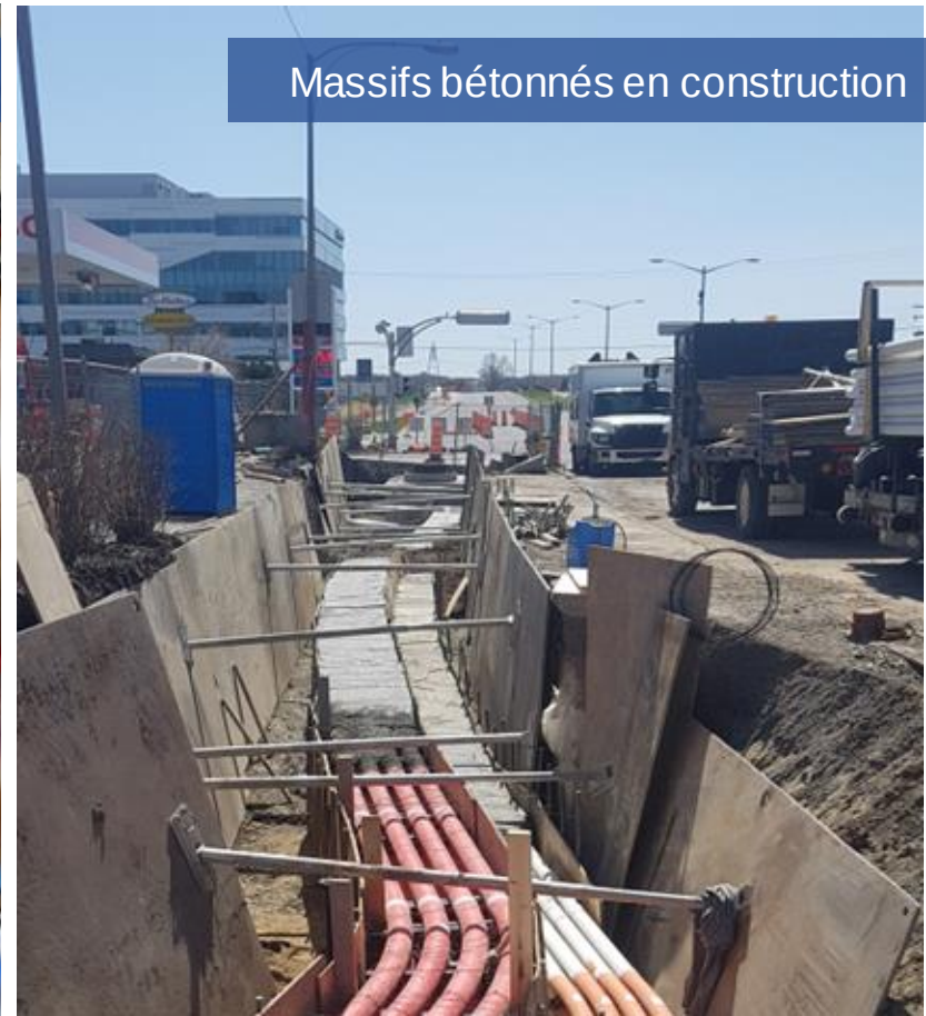
Installation de conduits
