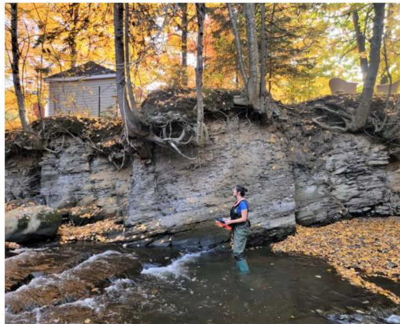
PAROIS SÉDIMENTAIRE AUX ABORDS D'UNE RIVIÈRE Source : Stantec
