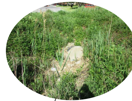
02 Cours d'eau canalisé sous la rue
