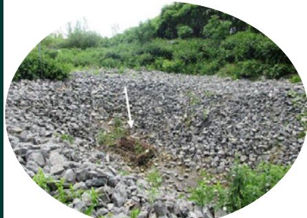
09 Cours d'eau canalisé sous la rue
