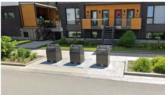
Figure 1 Exemple de conteneurs à déchet semi-enfouis à l'écoquartier de la Pointe-aux-Lièvres
