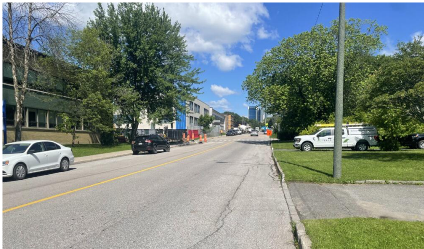
Route de l'Église direction nord (juillet 2025)* *Pendant les travaux d'agrandissement de l'école.
