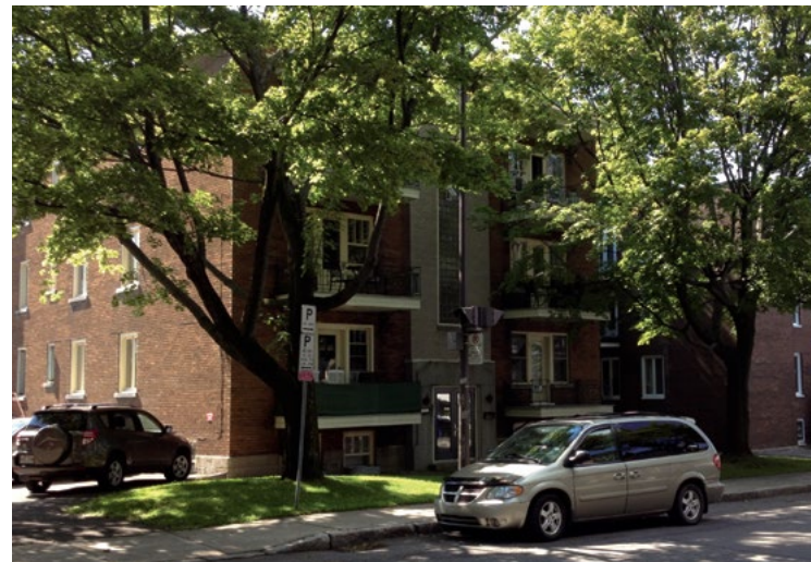
Bâtiments multifamiliaux sur l'avenue Calixa-Lavallée
