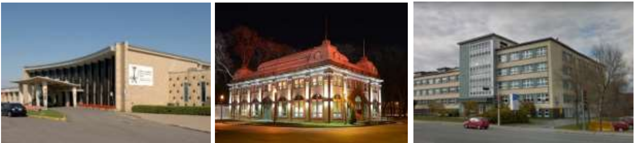
Figure 8 : Édifice de l'IRD PQ; Pavillon des arts; Centre d'Hébergement Christ-Roi
