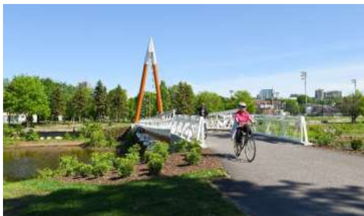
Figure 22 : Passerelle des Trois-Sœurs
