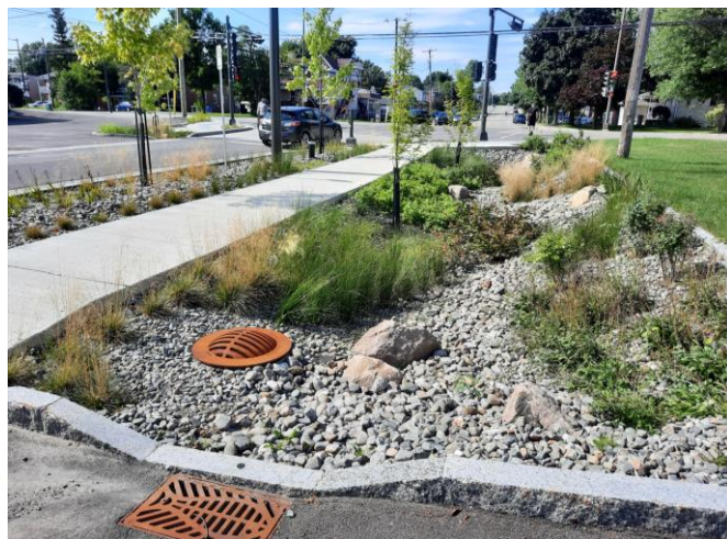
Exemple de noue drainante, Boul. Neuville, Québec
