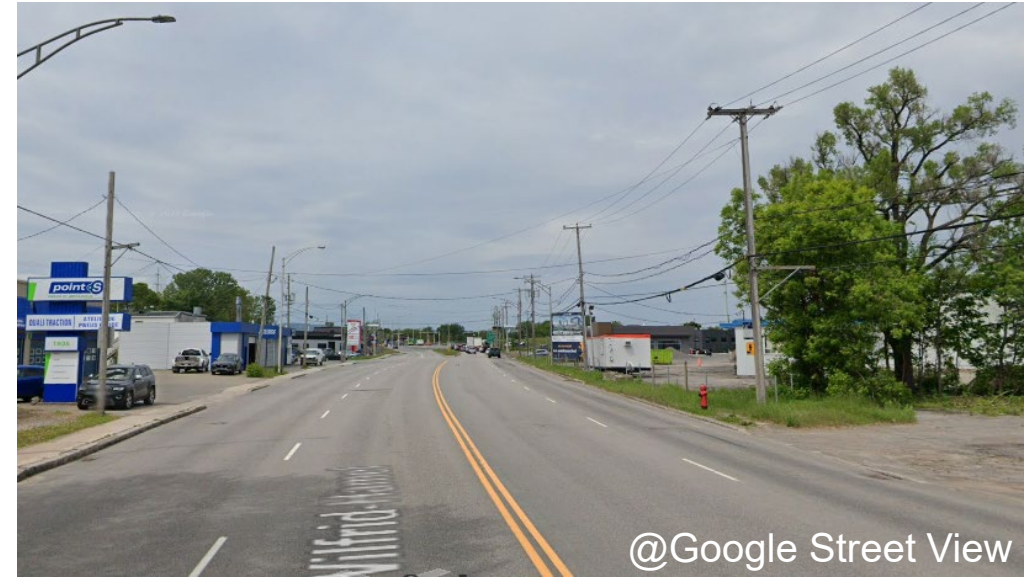
Entre la rue Côté et la rue du Haut-Bord
