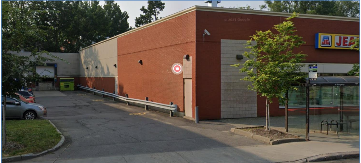
Exemple 1 avec tablier de manœuvre déjà aménagé : 1455, chemin Sainte-Foy
